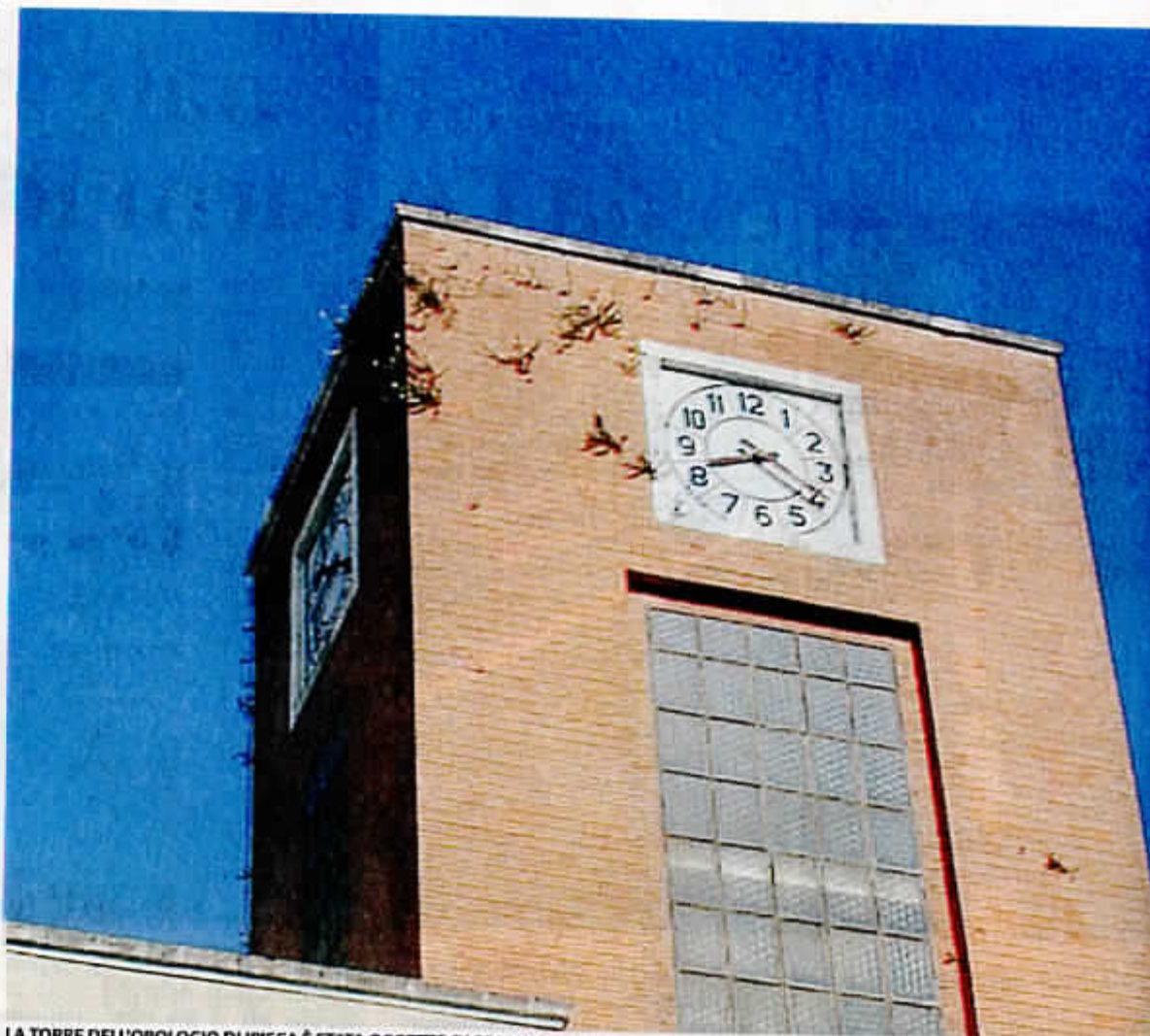
LA TORRE DELL'OROLOGIO DI ISPICA È STATA OGGETTO DI RESTAURO
